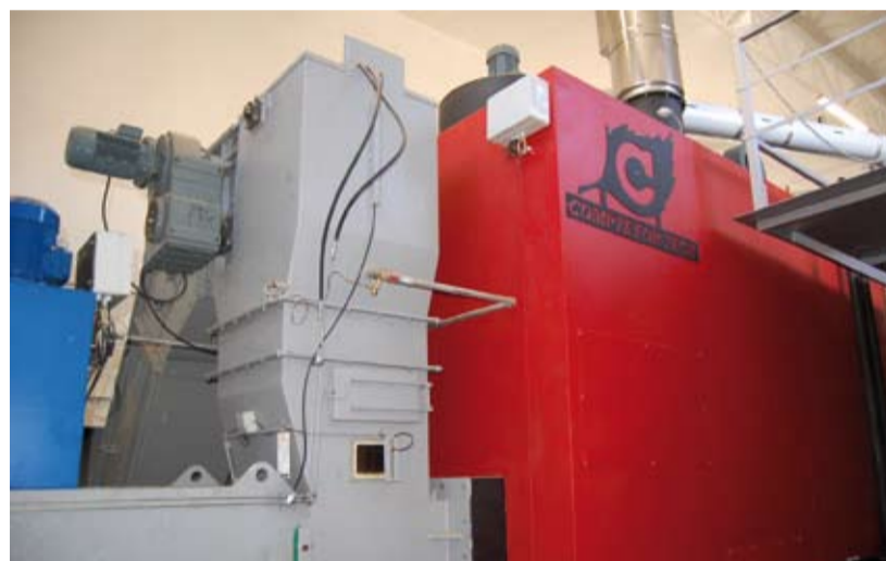
Zbiornik zasilający usytuowany między zaworem a tlokiem wtłaczającym opał tworzy zapasy paliwa, pozwalając na idealne wypełnienie popychacza w każdym cyklu zasilania.
