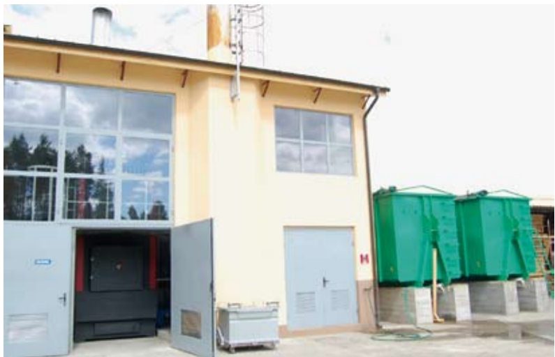
W kotłowni ZPD Panbah silosem są dwa mobilne kontenery z ruchomą podłogą.
